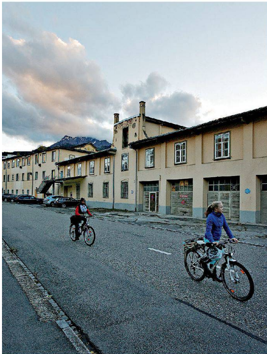
Die alte Teigwarenfabrik in Kriens wird bis zur Sanierung 2015 von Künstlern, Handwerkern und Kreativen genutzt.
