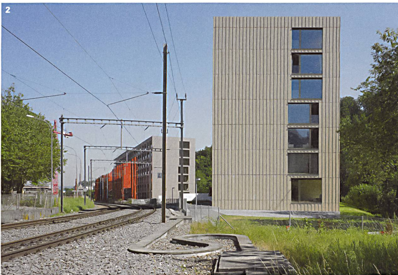
1 Die Holzbauten sind mit Keramikelementen verkleidet.
