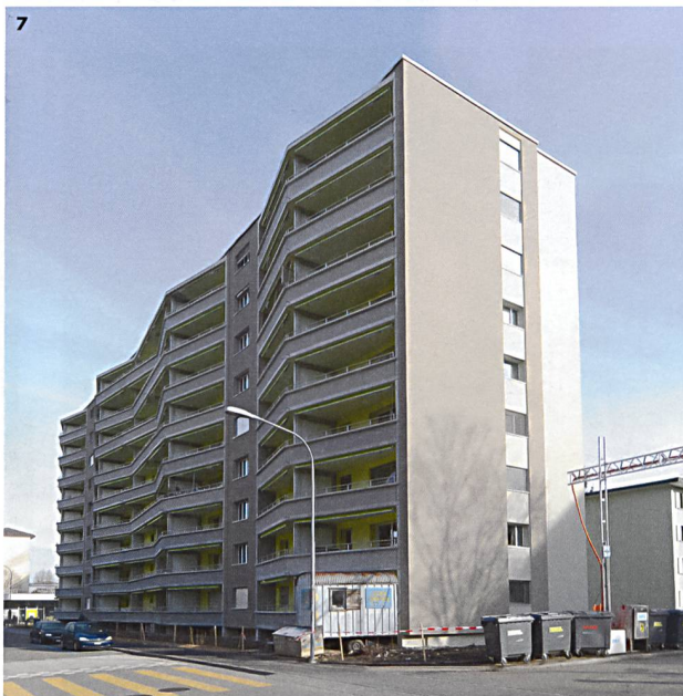
6 Bauzustand: Die alten Balkone sind vollständig entfernt, die neue Balkonschicht aus Fertigelementen wächst empor. 7 Die neuen trapezförmigen Balkone bestimmen das Fassadenbild auf der Strassenseite.
