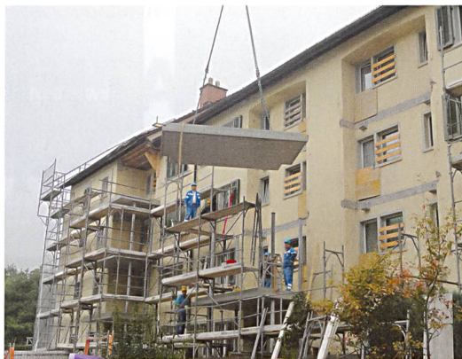
Montage der neuen Bodenplatten bei den oberen Balkonen.
