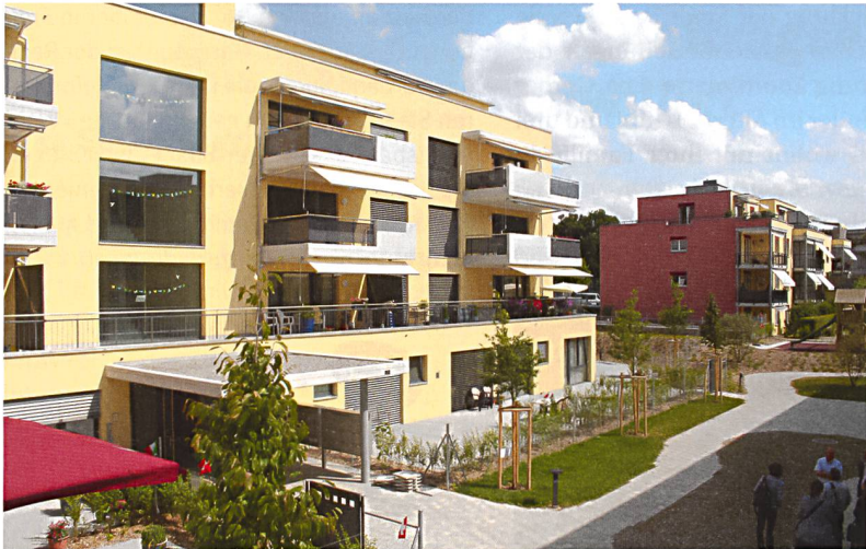
Siedlung Soligänter der Baugenossenschaft Gstückt in Bülach: Im Parterre links ist die Pflegewohnung eingerichtet. Ihr grosszügiger Aussenraum ist wegen der Demenzkranken eingezäunt.
