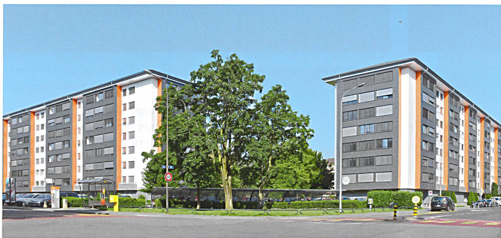
Vorher-nachher: Die Häuser aus den frühen 1950er-Jahren erhielten komplett neue Fassaden, die Balkone verwandelte man in verglaste Loggien.
