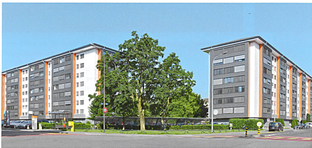
Vorher-nachher: Die Häuser aus den frühen 1950er-Jahren erhielten komplett neue Fassaden, die Balkone verwandelte man in verglaste Loggien.
