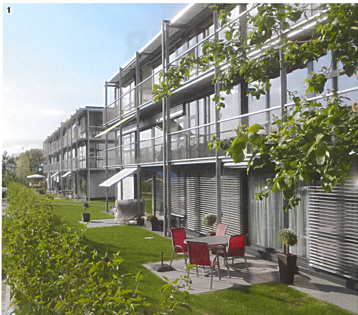
1 Wohnqualität innen und aussen: die Siedlung Meiefeld nach abgeschlossener Umgebungsgestaltung.
