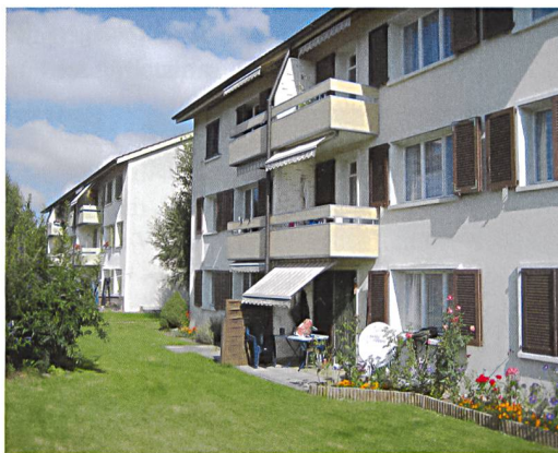
Vorher – nachher: Die Erweiterungsbauten sorgten für ein komplett neues Erscheinungsbild.
