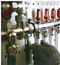
Titelbild: Finish nach der Reinigung oder Sanierung einer Fuss- bodenheizung: Montage von neuen Verteilern.
