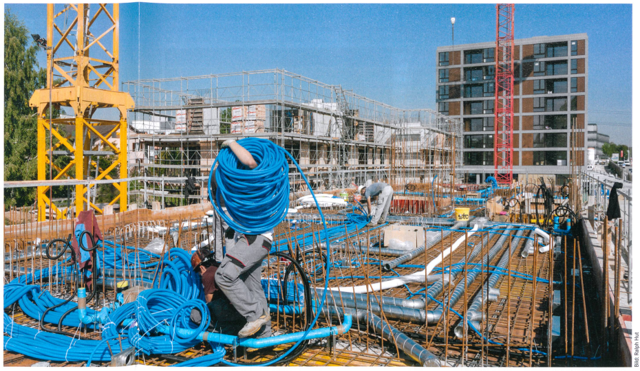
Einbau der Zu- und Abluftlüftungsrohre in der Siedlung Living 11 der ASIG. Das weit verzweigte Leitungsnetz ist an den zentralen Monoblock angeschlossen.
