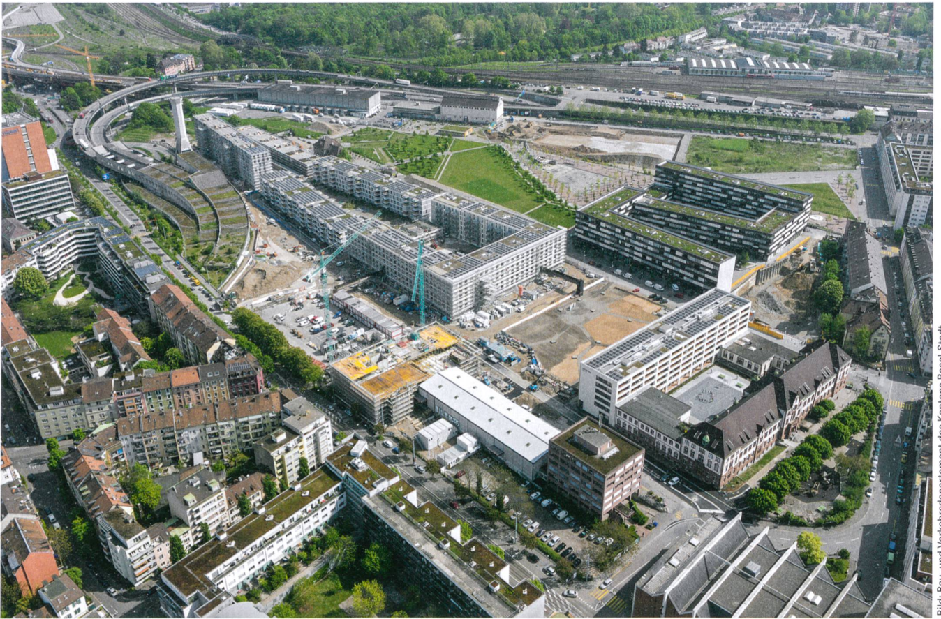
Bild: Bau- und Verkehrsdepartement des Kantons Basel-Stadt
