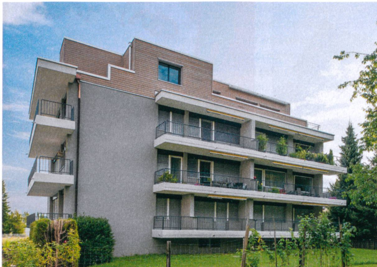
vor der Aufstockung
