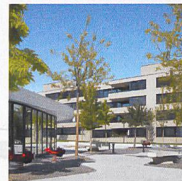
Wohnüberbauung Katzenbach II, Zürich
