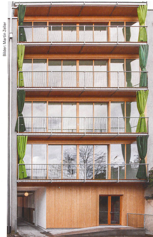
Auf der Hofseite erstellte man eine neue Raumschicht mit einer vollverglasten Holzbaufassade.
