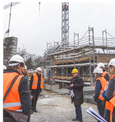
Die Regionalverbände auf der Kohlistieg-Baustelle.
