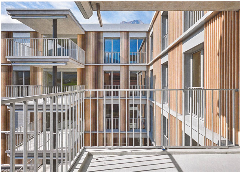
Einsicht erwünscht: Die Balkongeländer dürfen nicht abgedeckt werden.
