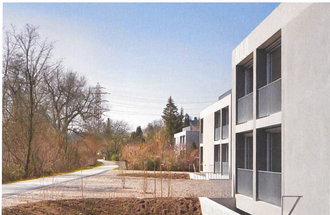
Nur ein Fuss- und Radweg trennt die drei Neubauten von der Aare.
