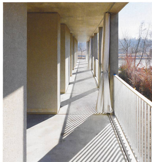
Die Laubengänge dienen der Erschliessung und als Terrassen.
