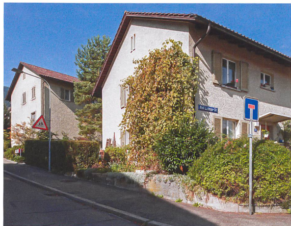
Zehn Etappen werden gemäss Masterplan bis 2050 ersetzt. Einige Siedlungen, darunter die 16. Etappe (im Bild), wurden neu als Schutzobjekte inventarisiert.
