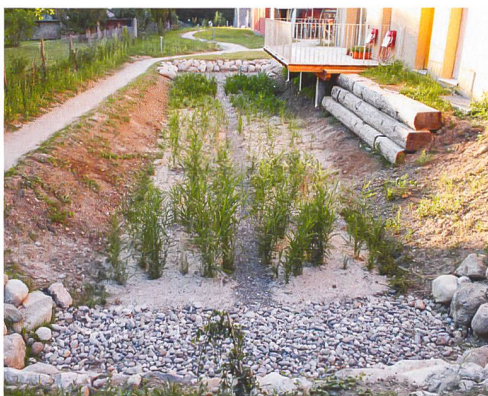
Das hier gereinigte Wasser wird anschliessend mit dem Regenwasser abgeleitet.
