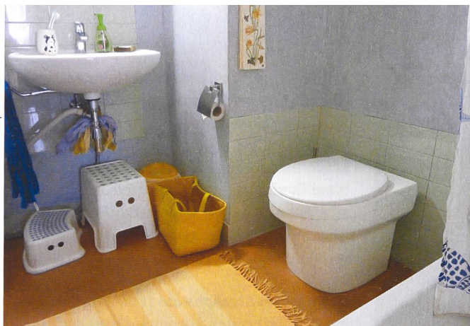
Von aussen betrachtet sehen die Toiletten in der Überbauung Cressy ziemlich normal aus.
