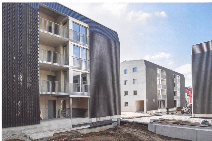
Die Erschliessung der Wohnungen erfolgt über Laubengänge.
