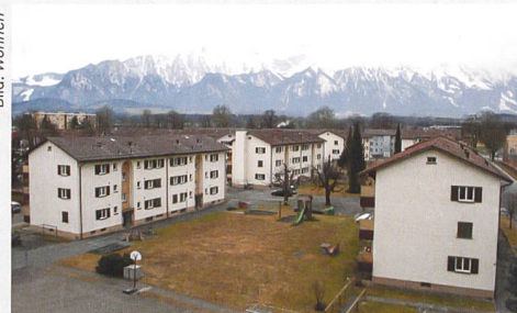
Am westlichen Stadtrand von Thun finden sich viele Genossenschaftssiedlungen, die erneuert werden müssen.
