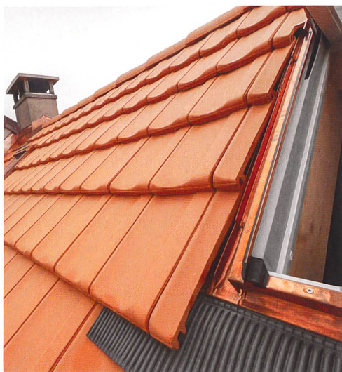
Blick auf ein erneuertes Dach.
