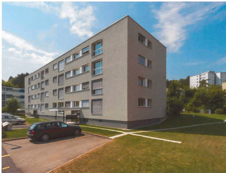
Gesamtsanierung MFH Am Brunnenbächli in Zollikerberg
