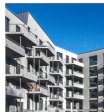
Die zentrumsnahe städtische Überbauung Kronenwiese in Zürich zeigt, wie Verdichtung und hohe ökologische Standards Hand in Hand gehen. Bild: Giorgio von Arb
