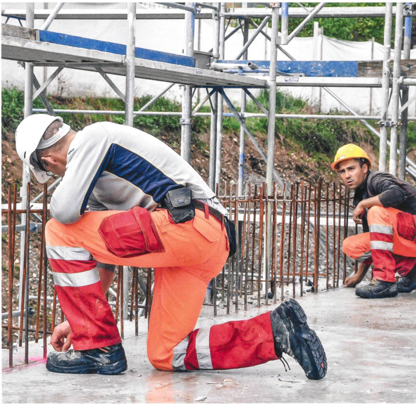
Konflikte zwischen verschiedenen Baupartnern können in allen Projektphasen entstehen – von Planung über Bau und Betrieb bis zum Rückbau.
