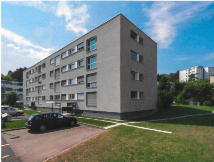
Gesamtsanierung MFH Am Brunnenbächli in Zollikerberg
