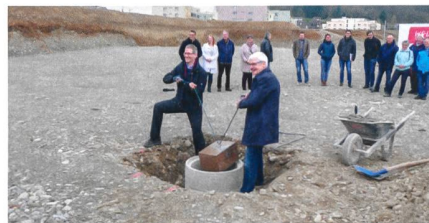
Coop-Vertreter Alfred Hubler und WGL-Präsident Charly Suter legten den Grundstein für die Neubausiedlung – eine Box mit Zeitdokumenten.
