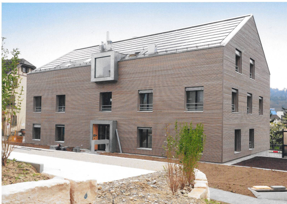
Blick von der Eingangsseite: Nicht nur das Baumaterial Holz ist nachhaltig, auf den Dächern wird auch Strom produziert.
