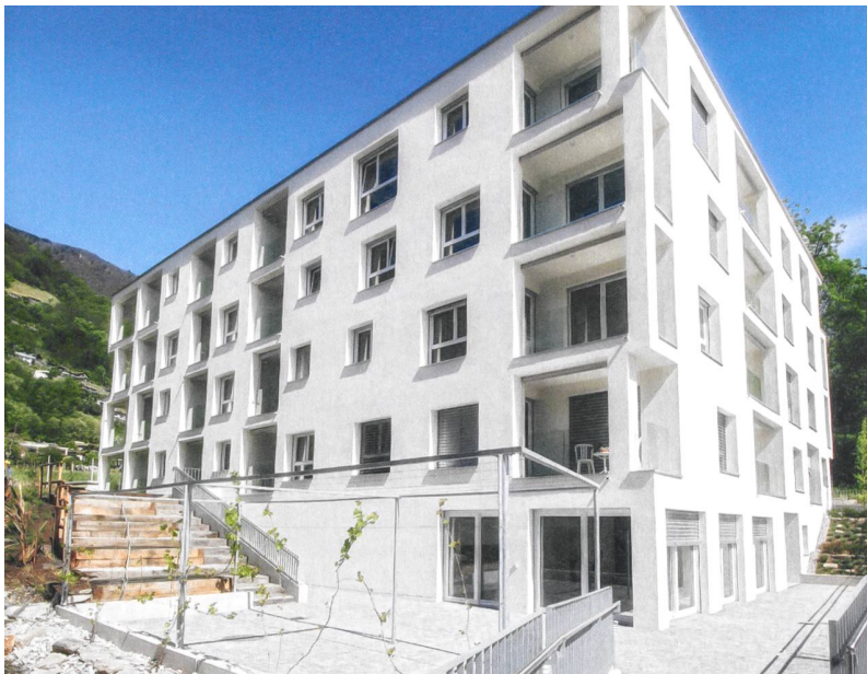
Jüngster Zuwachs im Alloggi-Portfolio: das Haus Riale C in Gordola. Es umfasst 44 günstige kleinere Wohnungen und ein Gemeinschaftsangebot.
