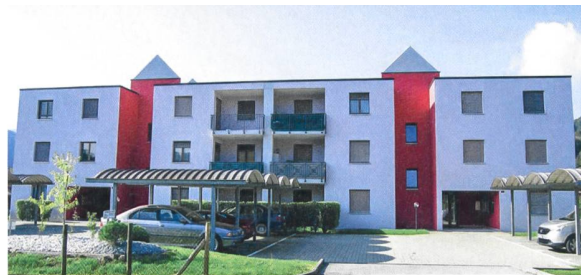
Ihre Überbauung in Caslano hat die Alloggi kürzlich erneuert.
