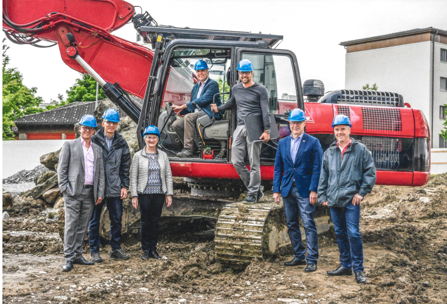
Am 6. Juni schritt die GBC zum Spatenstich für den Ergänzungsbau am Enikerweg. Von links nach rechts: Georges Helfenstein, Gemeindepräsident; Leonz Käppeli, Bauchef Vorstand GBC; Ruth Dössegger, Geschäftsleiterin GBC; am Schalthebel Josef Huwyler, Präsident GBC; Michel Tscherry, Archetage; Rolf Ineichen, Bauchef Gemeinde Cham; Arthur Sigg, Archetage.
