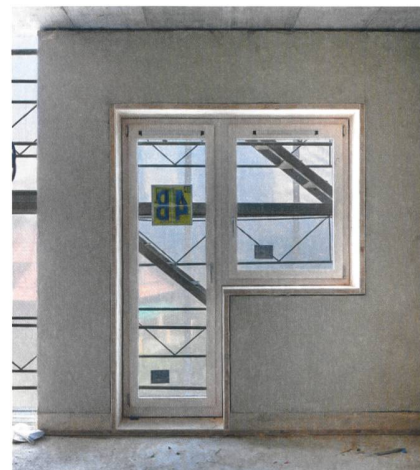
Das Stroh für die Isolierung ist in Elemente eingefügt, die aus Holz und Lehm bestehen. Bei der Vorfertigung arbeiteten Genossenschaftsmitglieder unentgeltlich mit.
