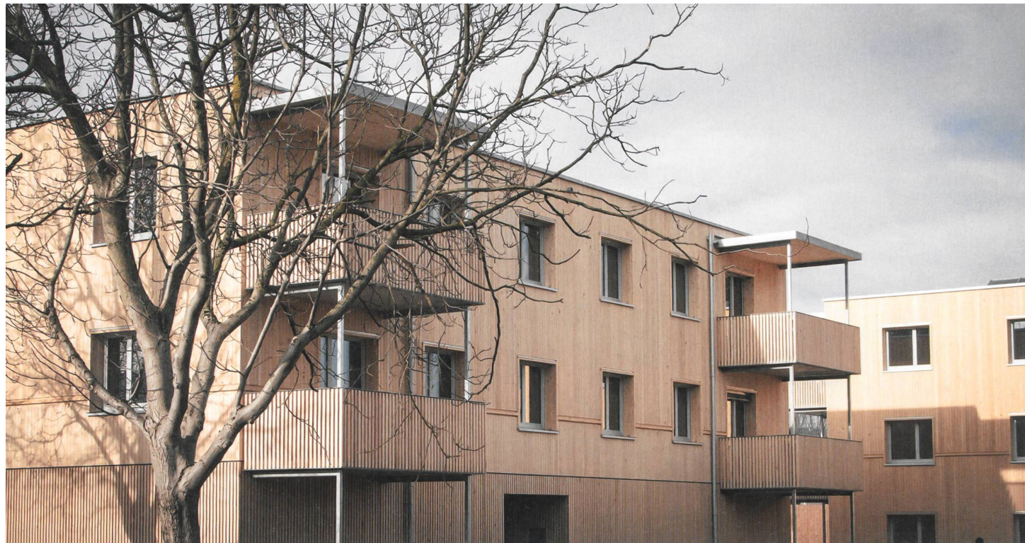
Jede Wohnung besteht aus drei vorgefertigten Modulen. Die gesamte Bauzeit dauerte nur drei Monate.
