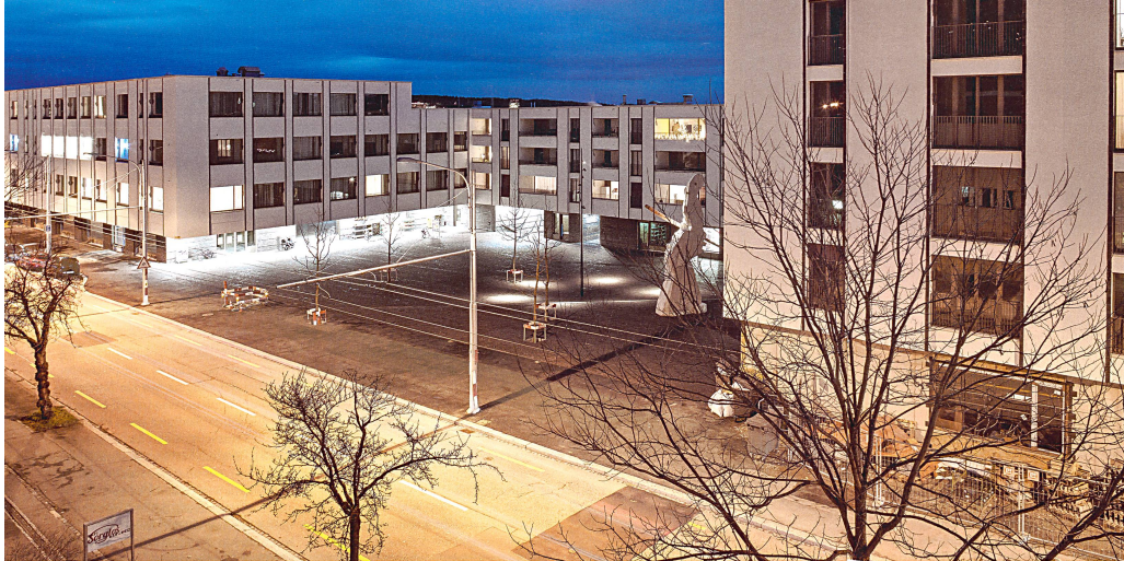
Mit der ersten Etappe des neuen Quartierzentrums konnte der öffentliche Friesenbergplatz eingeweiht werden. Er soll zum Treffpunkt werden. Über ihn sind diverse Läden, ein Restaurant sowie ein Gesundheitshaus erreichbar.
