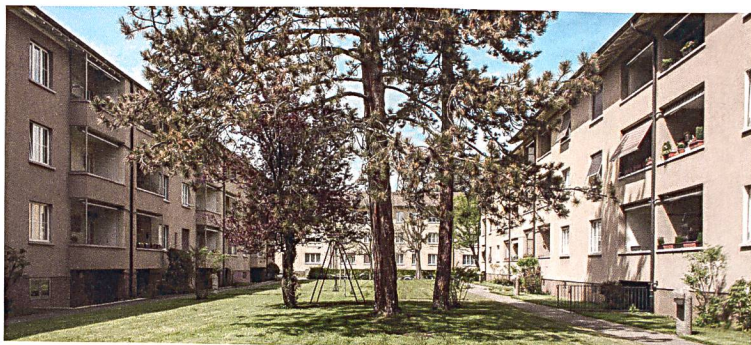
So präsentiert sich die Siedlung heute. Die Aussenräume werden nur wenig genutzt.
