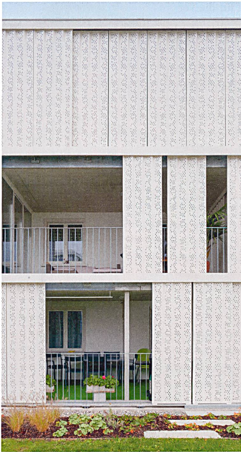
Schiebelamellen dienen als Sonnen- und Blickschutz.
