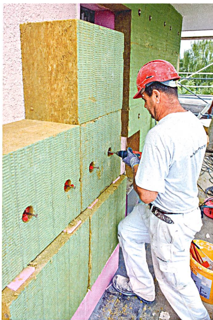
Die dicke Wärmedämmung gehört nach wie vor fest zur Erneuerungsdoktrin. Gemäss dem Energieberater Martin Ménard wäre es aber oft klüger, mit einer suboptimalen Gebäudehülle zu leben und dafür die Wärmeerzeugung zu ersetzen.
