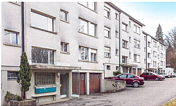
Der erneuerungsbedürftige Bau von 1969 wird durch zwei Häuser mit modernen Genossenschaftswohnungen ersetzt.
