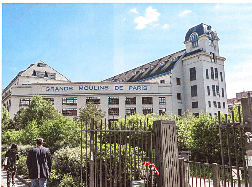
Eine ehemalige Mühle beim Parc des Moulins beherbergt heute die Universität Paris Diderot.
