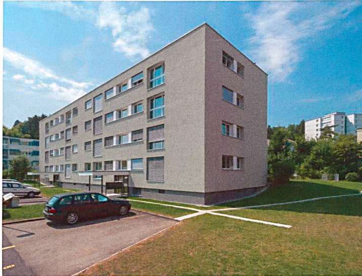
Gesamtsanierung MFH Am Brunnenbächli in Zollikerberg
