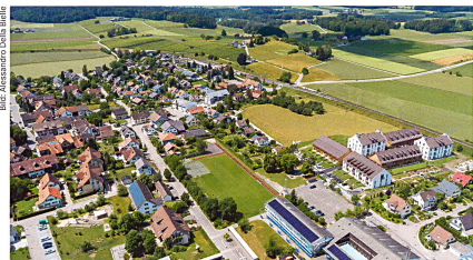
Die Siedlung Orenberg mit ihren sechs Bauten (rechts Mitte) befindet sich nur wenige Gehminuten vom Ossinger Dorfkern. Unterhalb liegt die Schulanlage, deren PV-Dächer auch einen Teil des Stroms für die Genossenschaftshäuser liefern.
