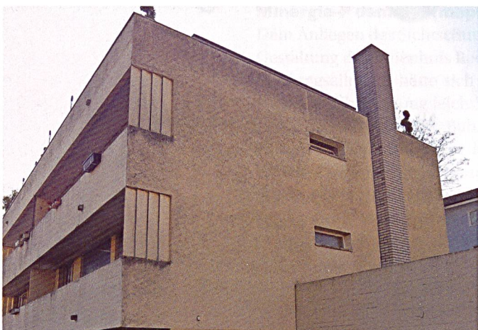
Die Fassade vor der Sanierung ...
