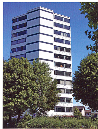
Das Gebäude erhielt eine neue hinterlüftete Fassade. Zudem wurden eine Reihe von Massnahmen zur Erdbbenertüchtigung ausgeführt.
