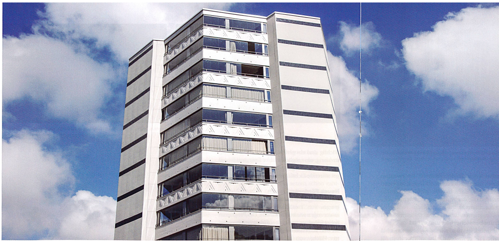
Das Hochhaus Fanghöfli ist im Inventar schützenswerter Bauten aufgeführt. Ersichtlich sind hier etwa die Ornamente an jeder zweiten Balkonbrüstung, eine Reverenz an den amerikanischen Architekten Frank Lloyd Wright.
