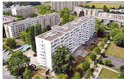
Das Gebäude liegt in der Cité de Meyrin, einem Gebiet, das von Grossbauten mit viel Grünraum geprägt ist.
