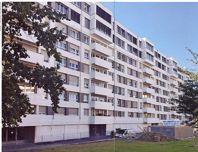
Das Scheibenhochhaus wurde um zwei Geschosse aufgestockt, die Fassaden wurden isoliert und erneuert. Links: früherer Zustand.
