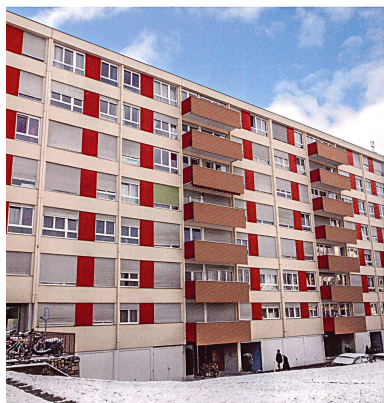
Das Scheibenhochhaus wurde um zwei Geschosse aufgestockt, die Fassaden wurden isoliert und erneuert. Links: früherer Zustand.
