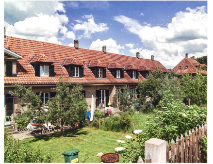
Die 212 Reiheneinfamilienhäuser unterscheiden sich sowohl in der Geschosshöhe als auch in den Details – und bilden doch eine Einheit.
