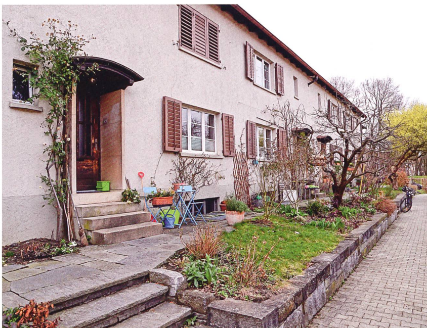
Blick auf die Eingangsseite.
