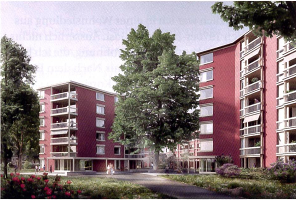
Rund 150 Alterswohnungen und ein grosses Angebot gemeinschaftlicher Nutzungen: Projekt von Bollhalder Eberle + Theres Hollenstein für die SAW-Neubauten Espenhof Nord.
