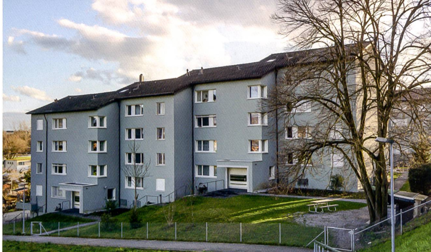
Blick auf die Eingangsseite.
