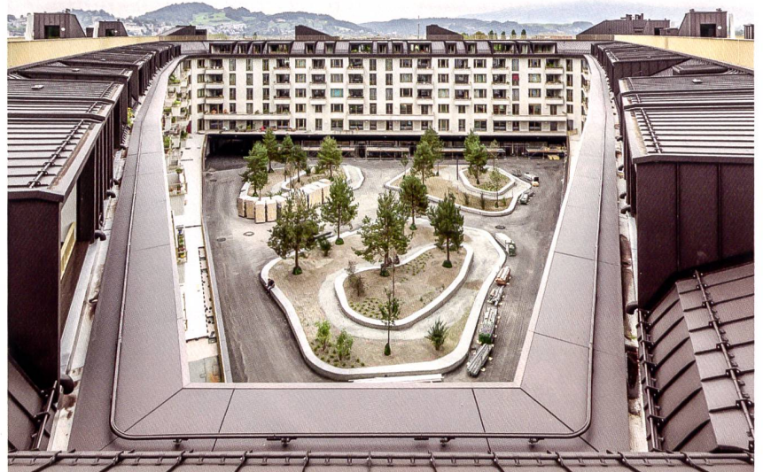
Wegen der darunterliegenden Einstellhalle ist der Wurzelraum für die Hofbepflanzung beschränkt. Der Landschaftsarchitekt setzte deshalb auf eine Bergflora – die drei Erhebungen nehmen darauf Bezug.
