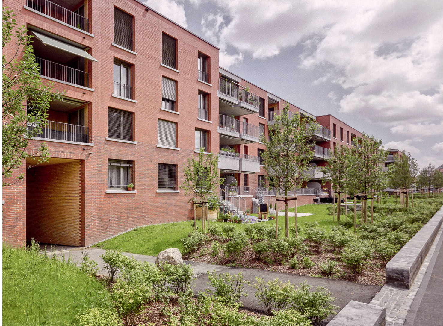
Auf der Strassenseite prägt die Klinkerfassade das Bild.
