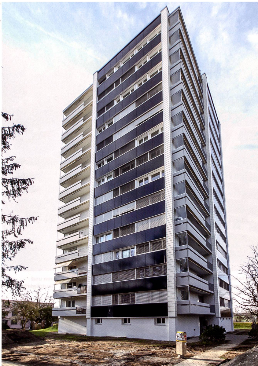
Das Hochhaus in Effretikon (ZH) wurde 2019 umfassend erneuert. Neben einer warm eingepackten Gebäudehülle installierte man an der Ost-, Süd- und Westfasse rund 470 Quadratmeter Solarmodule. Der so produzierte Strom (84 kWp Leistung) wird zum grössten Teil vor Ort verbraucht (Bauträgerin: Pensionskasse der Zürcher Kantonalbank, Anlage: Arento AG).
