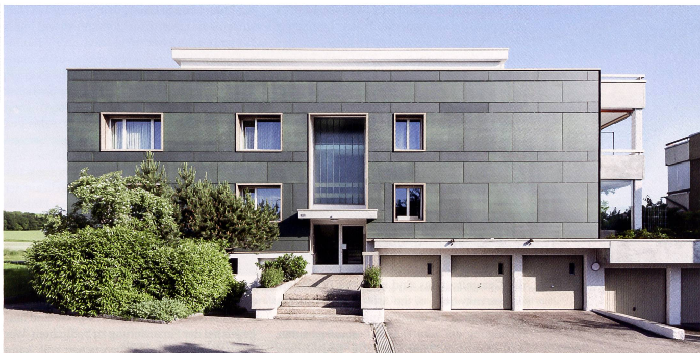
Die Umwelt Arena Schweiz realisierte in Opfikon (ZH) eine Mustersanierung mit einer Solarfassade, die auch ästhetisch überzeugt. Das Haus liefert 14 000 kWh Solarstrom pro Jahr, was etwa dem Verbrauch von fünf Haushalten entspricht.
