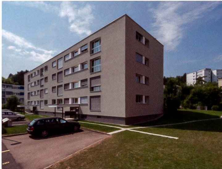
Gesamtsanierung MFH Am Brunnenbächli in Zollikerberg
